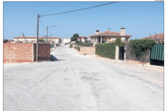
El carrer Carrerada en el qual es renovarà el paviment.
